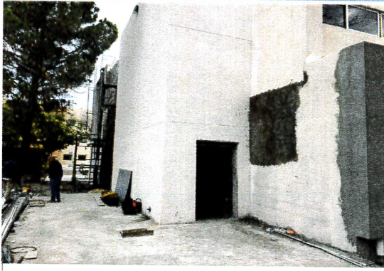
F1: Fachada principal
